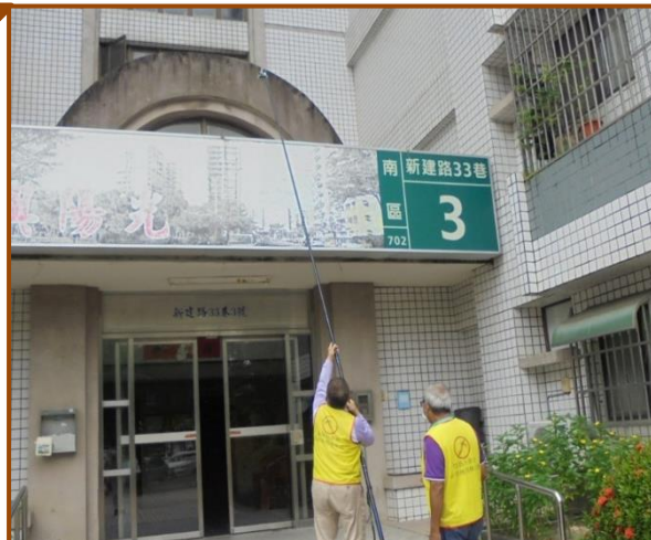
運用巡檢探測器巡檢高處屋頂並同步投藥
